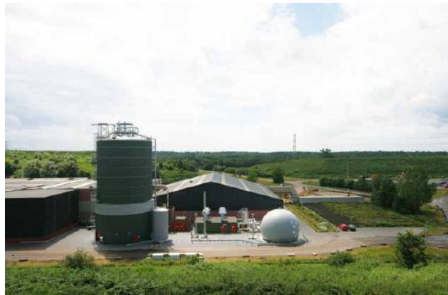
شکل ۲-۶۶ واحد هضم بی‌هوازی در هنگلو (کشور هلند)، ادغام هضم بی‌هوازی در یک واحد تولید کمپوست
