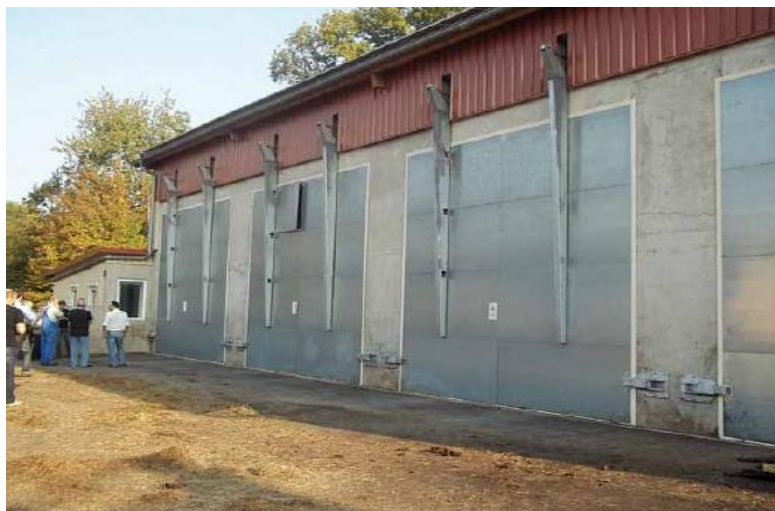
شکل ۲-۶۷ واحد هاضم خشک ناپیوسته (گاراژی) در آلمان
